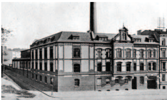
Elektrownia przy Franzosischestrassen
