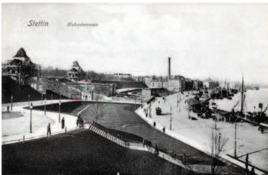
Wały Chrobrego w budowie, w tle wielki komin elektrowni
