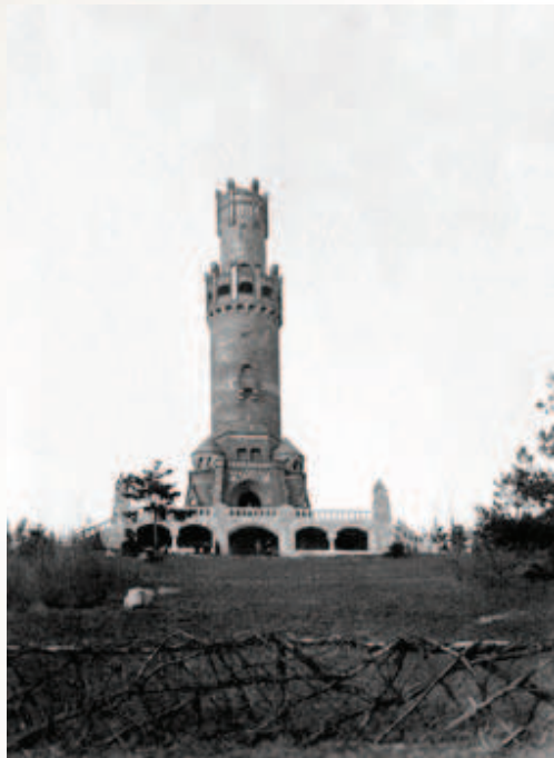
Wieża Quistorpa – zdjęcie z 1908 roku
